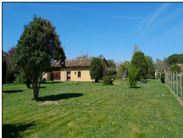
vB3 : vue vers le nord-ouest
