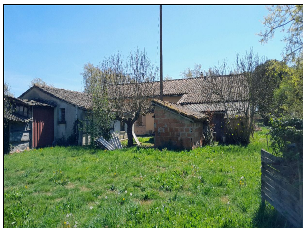
vL3 : façade nord de L1 et des dépendances
