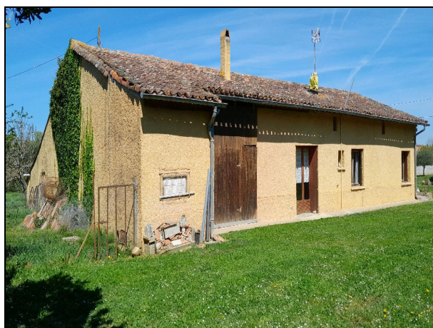
vL1 : façade sud de L1
