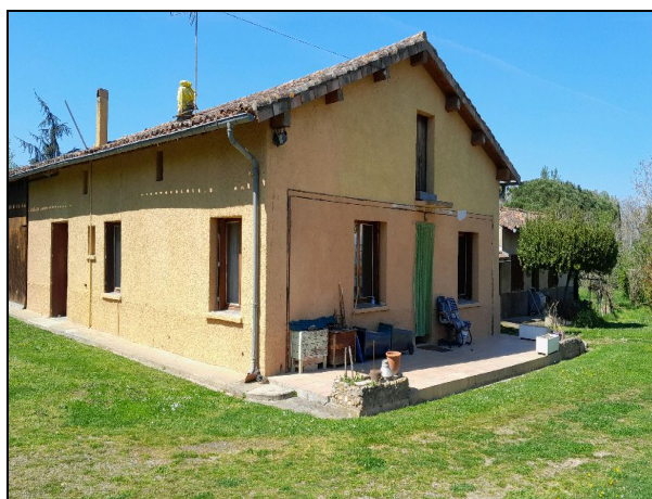
vL2 : façades sud et est de L1
