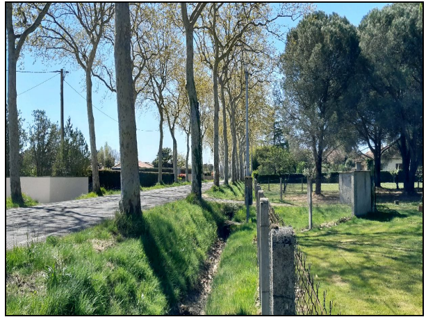
vH2 : fossé H2 en limite sud de la parcelle, le long de la D824 route de Bayonne
